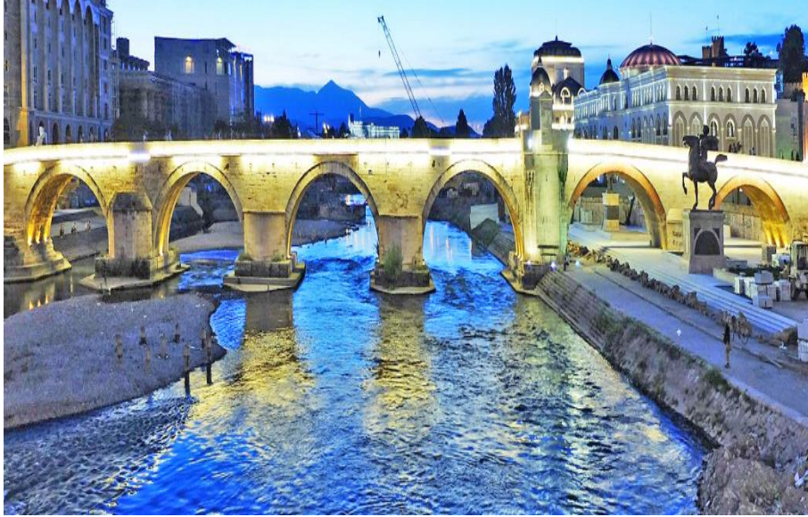
Şekil 3. Vardar Köprüsü Güneydoğu Yönünde Kuzeybatıya Doğru Bakış (Veysel Özbey Arşivi, 2016)
