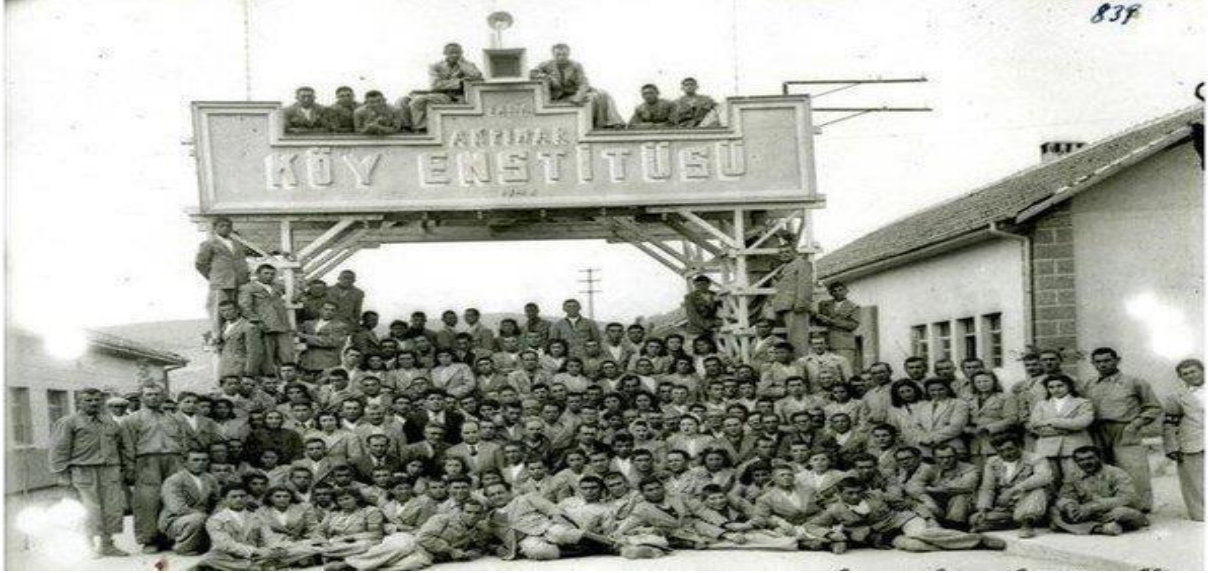
Akpınar Köy Enstitü Giriş Kapısı
