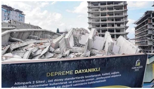
Şekil 18. Depremden sonra Altınpark 2 Sitesi (Gazete Vatan, 2023)
