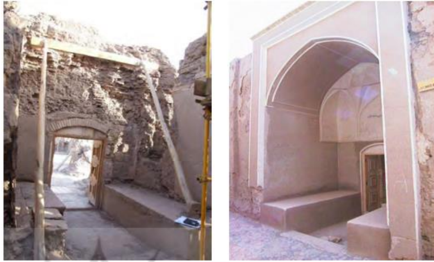
Şekil 9 (a) Ulu Caminin deprem hasarlı kapısı; (b) Ulu Caminin kapısının restorasyon sonrası görünümü (UNESCO World Heritage Center, 2004; Rouhi 2017)
