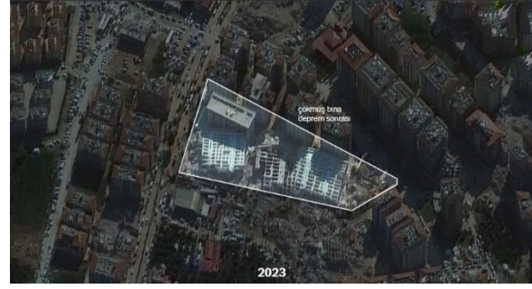
Şekil 7. 2023 yılında yıkılmış yapı (Hubbard ve diğerleri, 2023)
