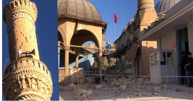
Şekil 9. Deprem sonrası şerefe kısmından hasara uğrayan Şanlıurfa Köprü Camii minaresi (Koruma Kurulu Hasarlı Camiyi Yıkma İçin Neye Bekliyor, 2023)
