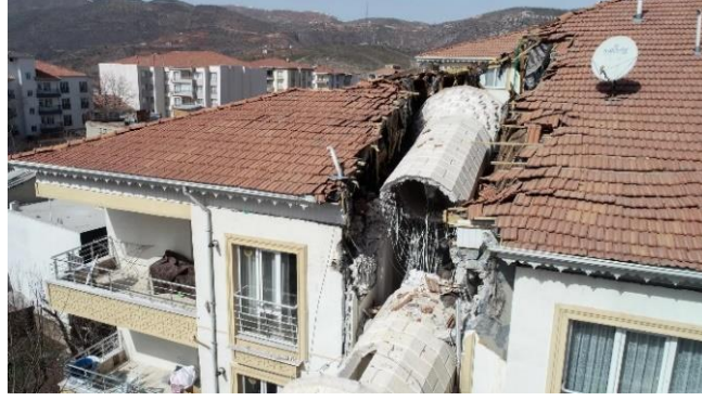
Şekil 6. 6 Şubat depremi sonrası Adıyaman Hacı Gani Diler Camii'nin yıkılan minaresi (Depremde yıkılan minare 3 katlı apartmanın üzerine devrildi, 2023)
