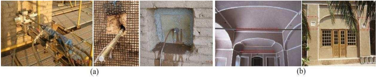
Şekil 12. (a) Arg-ı-Bam 1 No'lu Kule'de bağlama ve ankraj işlemi ve (b) Bam Kalesi'ndeki Sistani Evi'nde bağlantı çubuklarının bağlanması ve ankraj ile duvar-çatının iç takviyesi (Aveta, Marino ve Rouhi, 2017).
