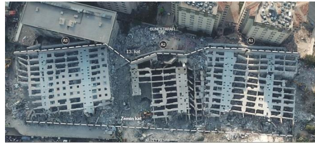
Şekil 9. Rönesans Rezidans'ın yıkılmış hali (Hubbard ve diğerleri, 2023)
