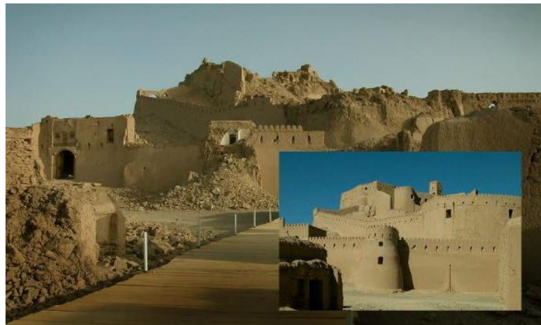
Şekil 4. Arg-ı Bam üst kalesi depremden önce (ön fotoğraf) ve depremden sonra (arka fotoğraf) (Mokhtari ve Shad, 2008)
