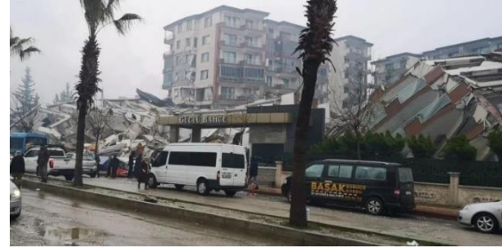
Şekil 17. Depremde yıkılan bloklar duvar (Gazete Duvar, 2023)
