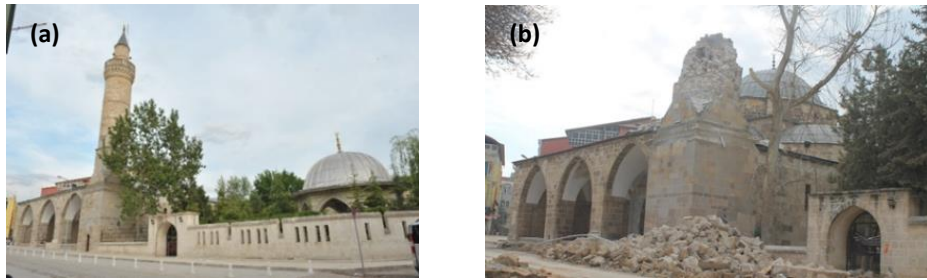
Şekil 20. Elbistan Ulu Camii (a) Deprem öncesi (Kahramanmaraş Şehir Rehberi, t.y.), (b) Deprem sonrası (Kahramanmaraş'ta 700 yıllık tarihi cami, 2023)
