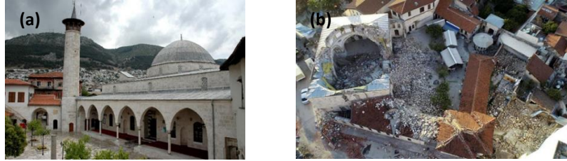
Şekil 26. (a) Hatay Habibi Neccar Camii deprem öncesi (T.C. Antakya Kaymakamlığı, t.y.), (b) Hatay Habibi Neccar Camii deprem sonrası (Antakya'daki 14 asırlık Habib-i Neccar Camisi, 2023)
