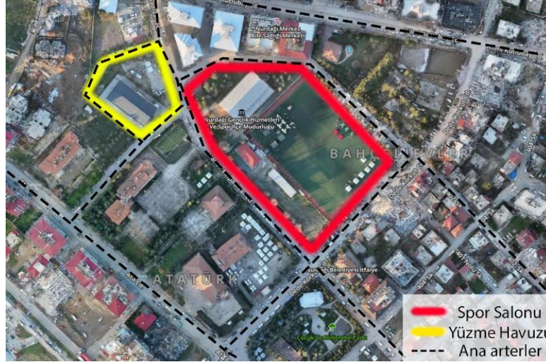
Şekil 20. Spor Salonu'nun çevresiyle ve toplanma alanlarıyla ilişkisi (Google Haritalar) (Deprem sonrası kuşbakışı görünüş) (Google Earth kullanılarak üretilmiştir.) (Koç, 2023)
