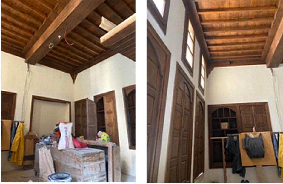
Şekil 10. 283 parsel yapısına ait iç mekan görselleri
