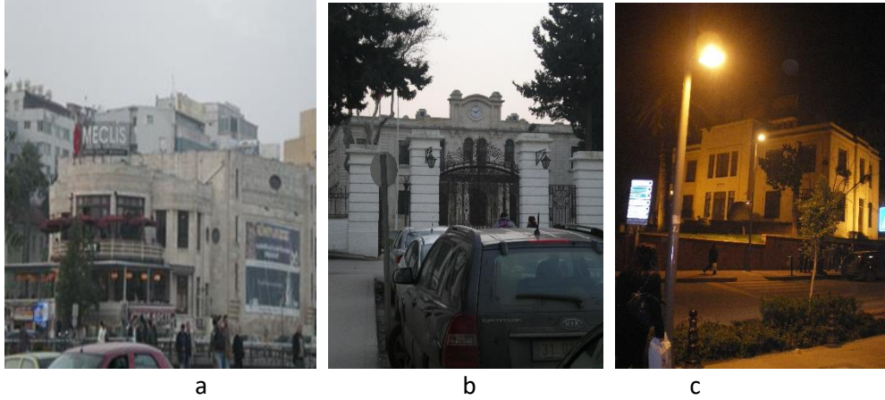
Şekil 6. Deprem öncesi tarihi Valilik, Belediye ve Meclis binası (Bozkurt, 2020)
