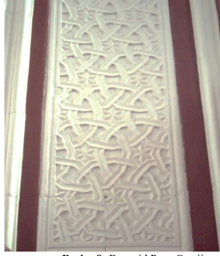
Resim 8: Bayezid Paşa Camii mihrabı bordür detayı. (Yazarın kişisel arşivindedir)
