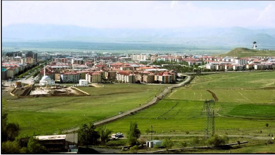
Fotoğraf 1: Müftü Solakzade Mahallesi (Çekim yönü kuzey), 21.05.2021.
