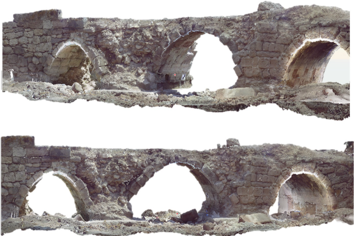
Şekil 4. Köprünün alt kısımlarının detaylı 3B nokta bulutu.
