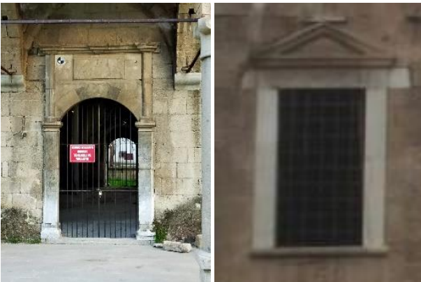
Şekil 13. Kapı ve pencere söveleri [36]
