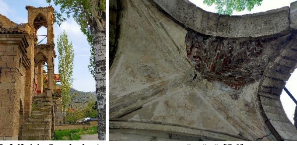
Şekil 11. Çan kulesi ve çapraz tonoz örtüsü [36]
