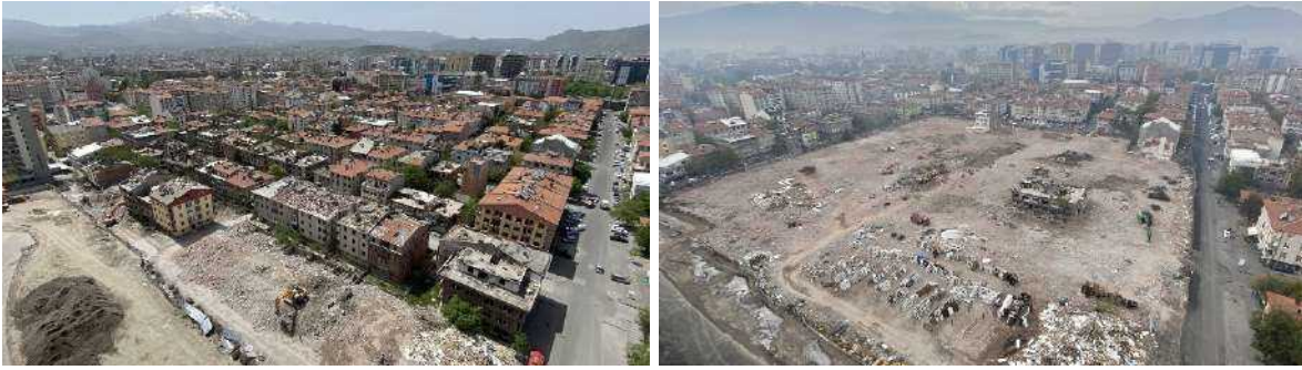
Görsel 3. Yıkım öncesi ve sonrası mahalleden bir bölüm Kaynak: (Kayseri Büyükşehir Belediyesi, 2021)
