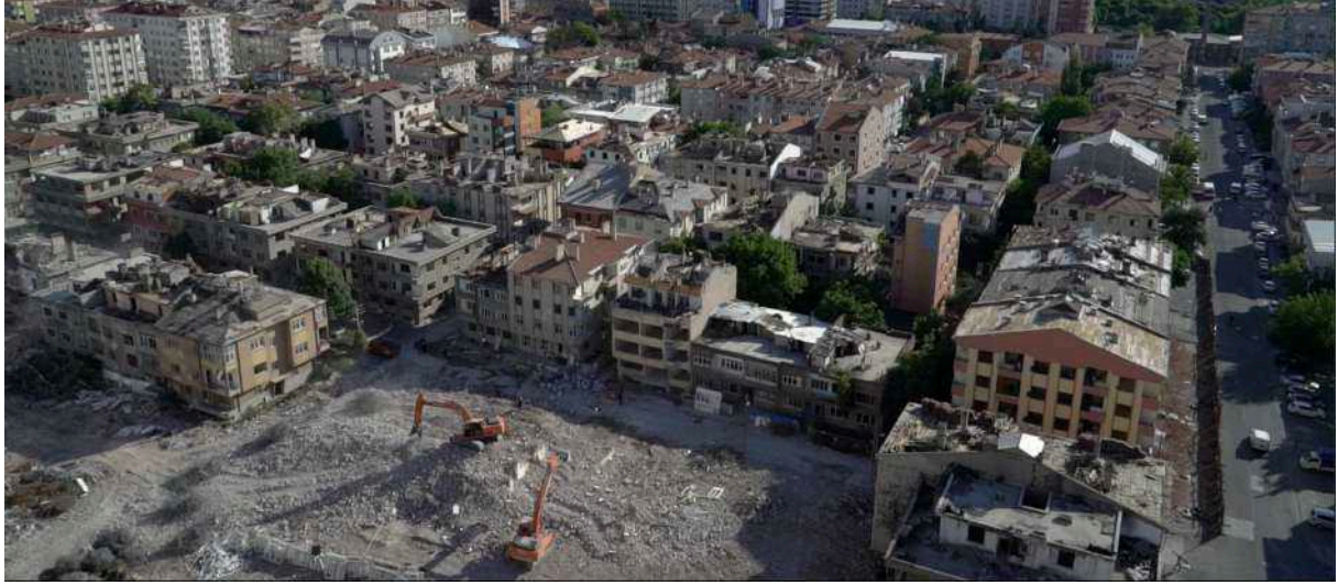
Görsel 8: Yıkım için boşaltılmış olan bölgenin genel görünümü (Arşiv amacıyla proje kapsamında çekilen görüntülerden).
