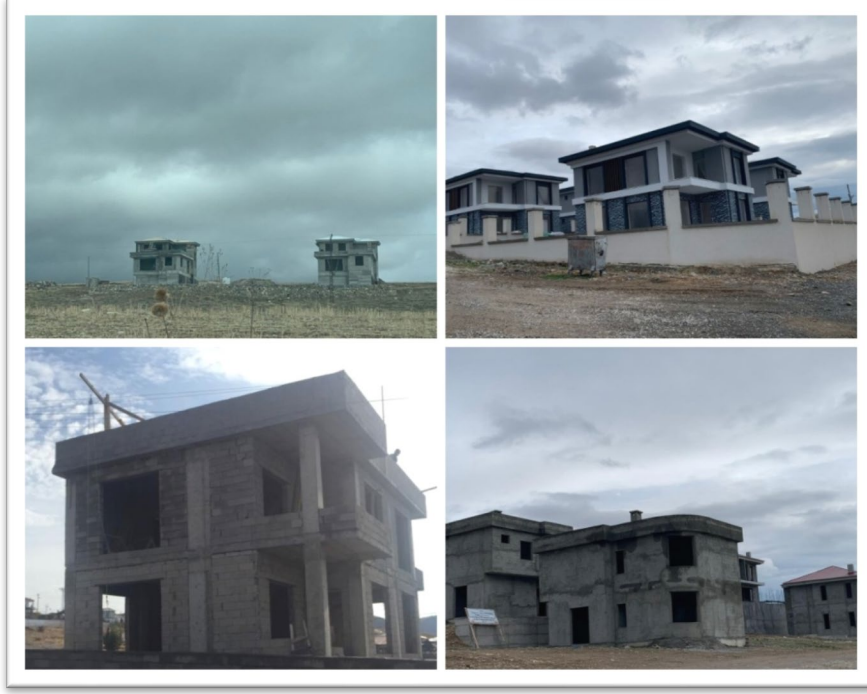
Foto 1. İnşaat Halindeki İkincil Konutlar
