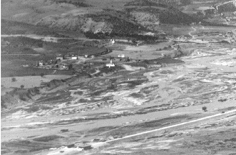
Şekil 1. 13 haneli Karabük Köyü, 1934 (Kardemir Demir-Çelik Fabrikaları Görsel Arşivi)
