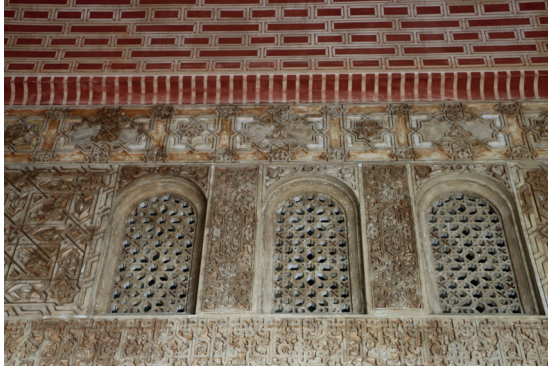
Resim 20: Cephe Süslemeleri ve Kûfi Yazı Kuşaklarından Bir Örnek
