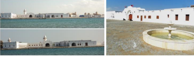
Fotoğraf 13a-b. Gümrük Binası restorasyon sonrası 2015 (Burak Arslan)
