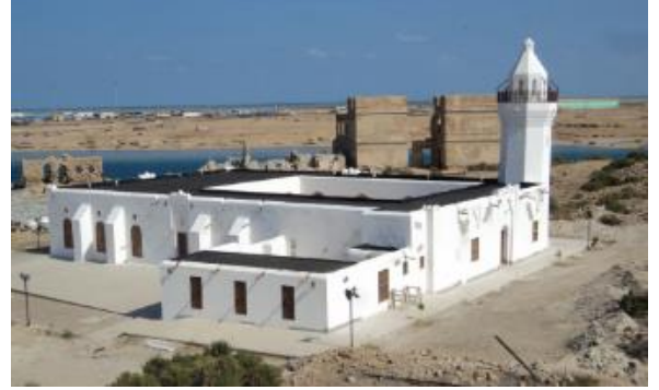
Fotoğraf 15c. Şafî Camii, restorasyon sonrası (2015)
