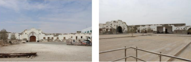
Fotoğraf 14a-b. Gümrük Binası (2022). Restorasyon sonrasında zaman içerisinde rüzgâr badanaları silmiştir.
