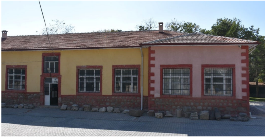
Görsel 6. Kemerhisar Etiler İlkokulu Kırma Çatı.
