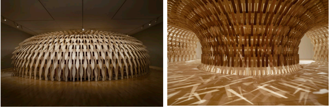
Şekil 20. Melburn’de sergilenen sökülüp takılabilir ahşap strüktür (KKAA, 2020)
