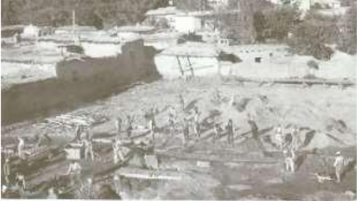
Şekil 20. Hastane inşaatı (1945) (Foto Renk Arşivi)
