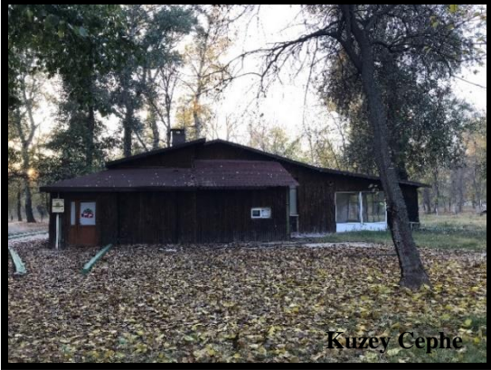
řekil 4.10 Kafe-restoran yapısının kuzey cephesi (Orijinal 2022)
