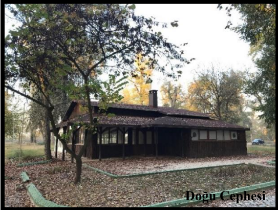
řekil 4.11 Kafe-restoran yapısının doęu cephesi (Orijinal 2022)
