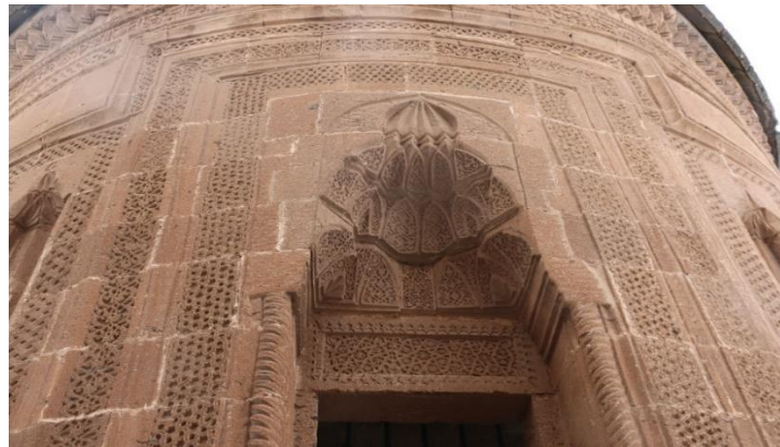
Görsel 25. Ahlat Emir Bayındır Türbesi taçkapı süsleme detayı (Bekmez Yelen, 2017)
