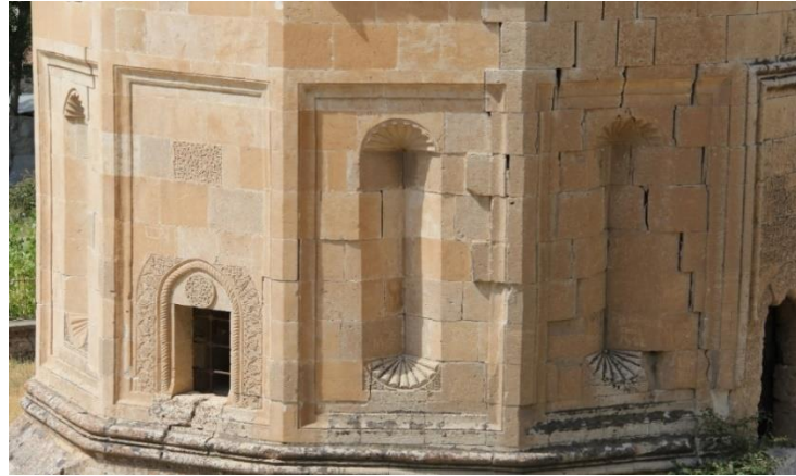
Görsel 20. Erciş Kadem Paşa Hatun Türbesi cephe detayı (Bekmez Yelen, 2019)
