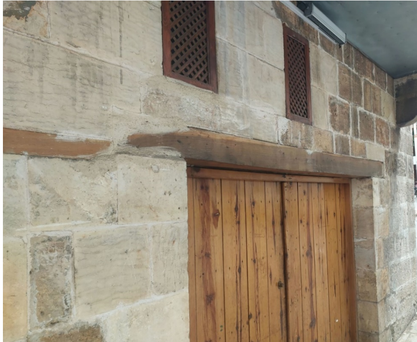
Şekil 9. Açıklık boyutu fazla olmasına rağmen hasar görmemiş bir duvar (An undamaged wall despite the large opening size)
