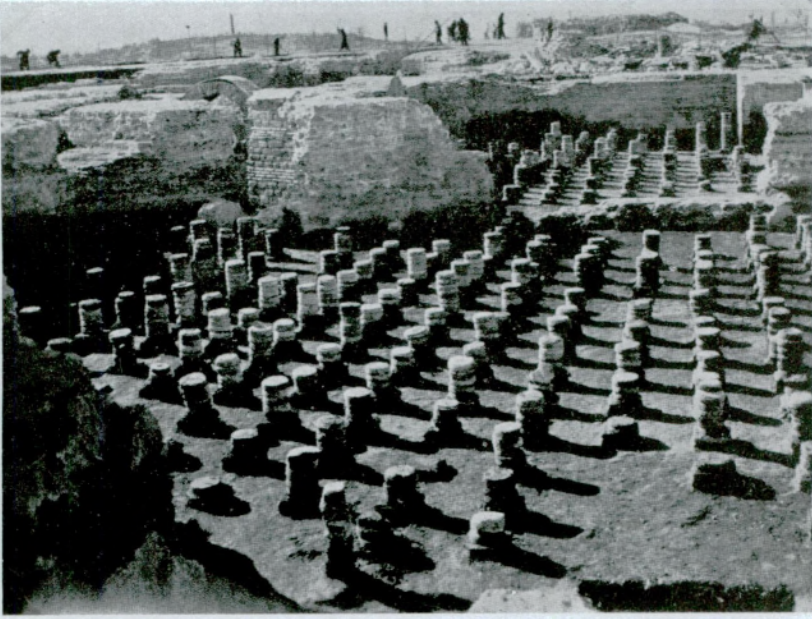
Döşemeyi taşıyan mesnet direkleri. «Yuvarlak tuğlalar»
