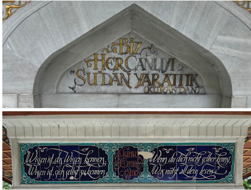
Şekil 16. Viyana Yunus Emre Çeşmesi'nin Batı Cephesindeki Yazıların Konumu ve Detayı.
