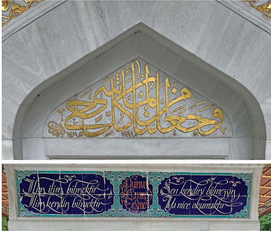
Şekil 13. Viyana Yunus Emre Çeşmesi'nin Kuzey Cephesindeki Yazıların Konumu ve Detayı.
