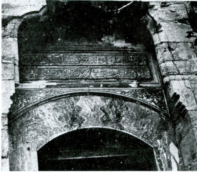
Hüseyin Paşa türbesi tamirden sonra ve kapısı üstündeki kitabe
