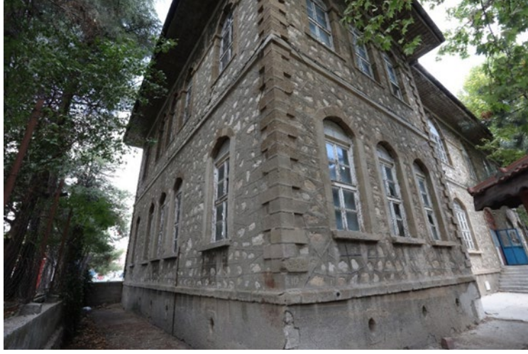
Şekil 11. Senirkent Turan İlköğretim Okulu güneybatı cepheden genel görünüm (Kişisel arşivden)
