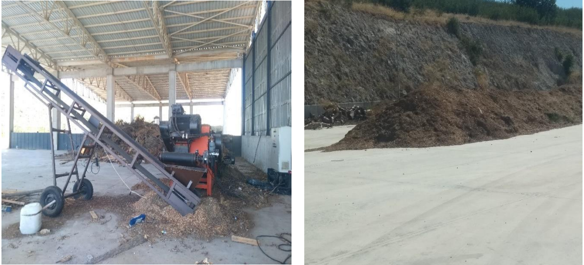
Şekil 7. Balıkesir Katı Atık Düzenli Depolama Tesisi Kompost Üretim Alanı
