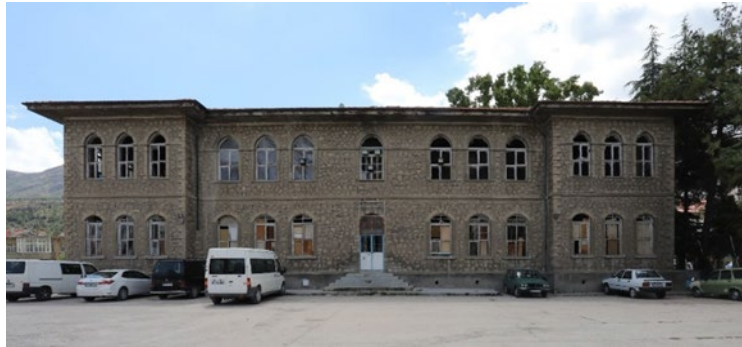
Şekil 10. Senirkent Turan İlköğretim Okulu kuzey cepheden genel görünüm (Kişisel arşivden)
