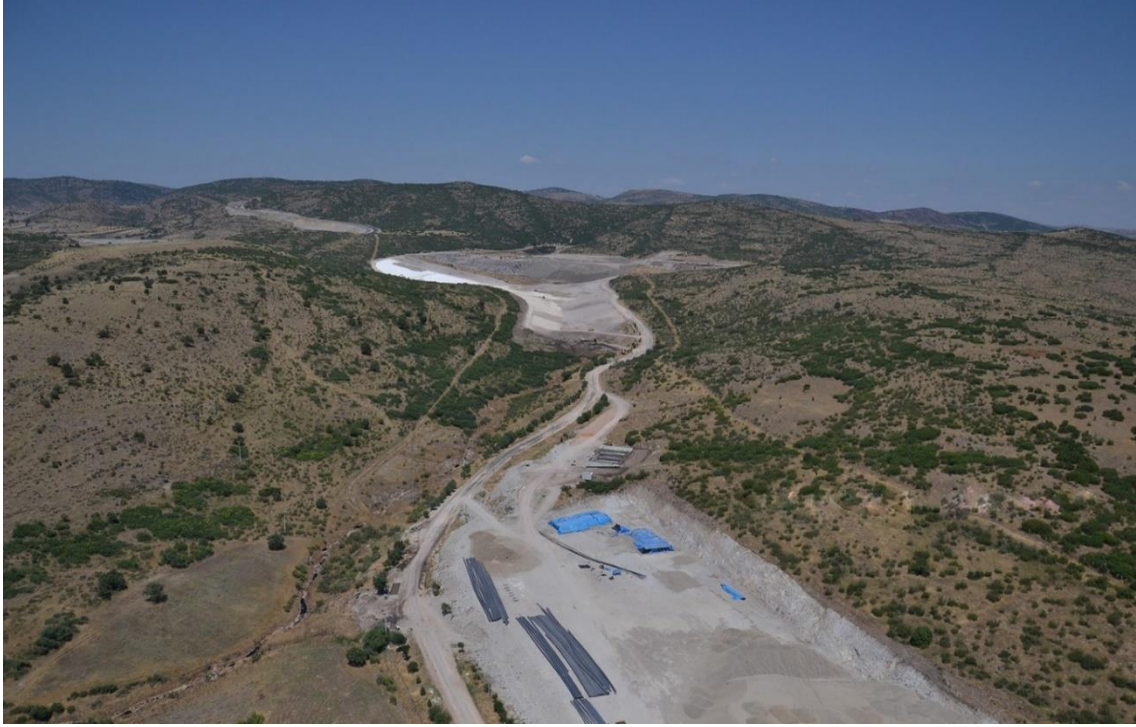
Şekli 6. Eysel Katı Atıkların Döküm Alanı İnşası Aşaması (Çevre Koruma ve Atık Yönetimi Birimi, 2022)
