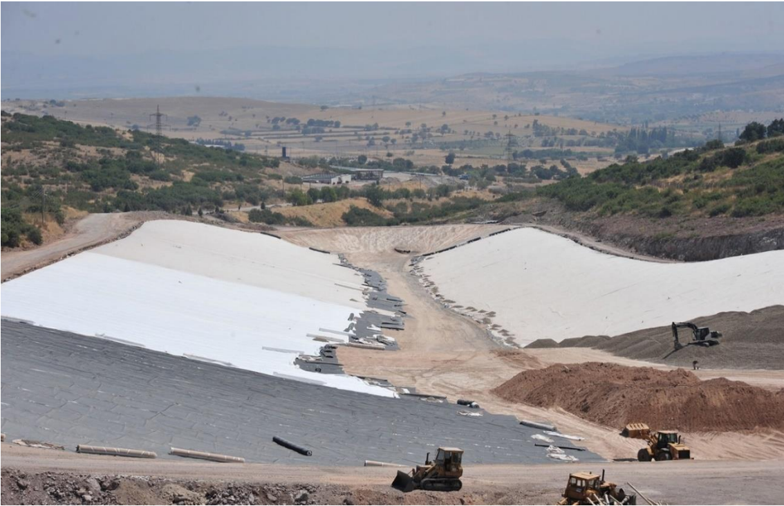
Şekli 5. Eysel Katı Atıkların Döküm Alanı İnşası Aşaması (Çevre Koruma ve Atık Yönetimi Birimi, 2022)
