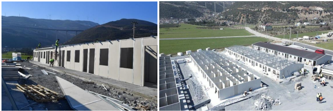
Şekil 10: Prefabrik yapı kurulumu (Anadolu Ajansı, 2023)
