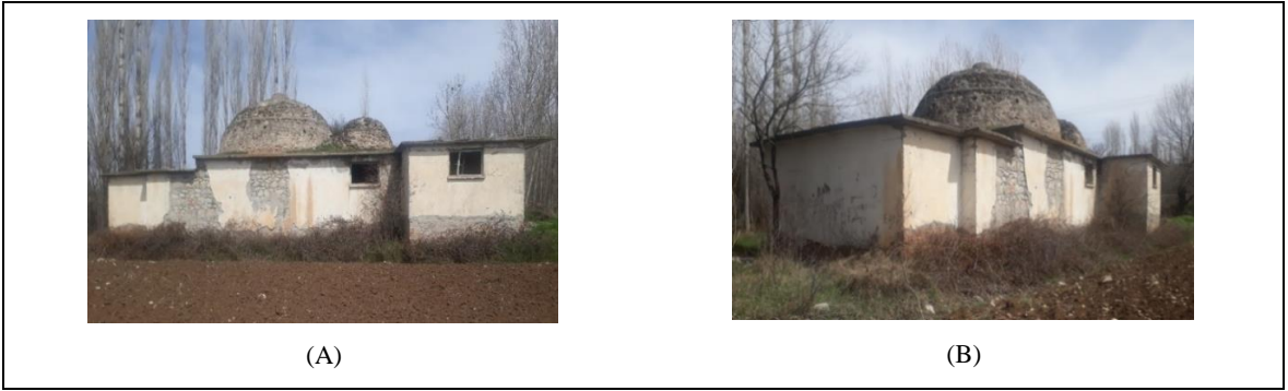
Foto 7. Hamamın genel görünüşleri (A) doğu cephesi, (B) güney cephesi.
