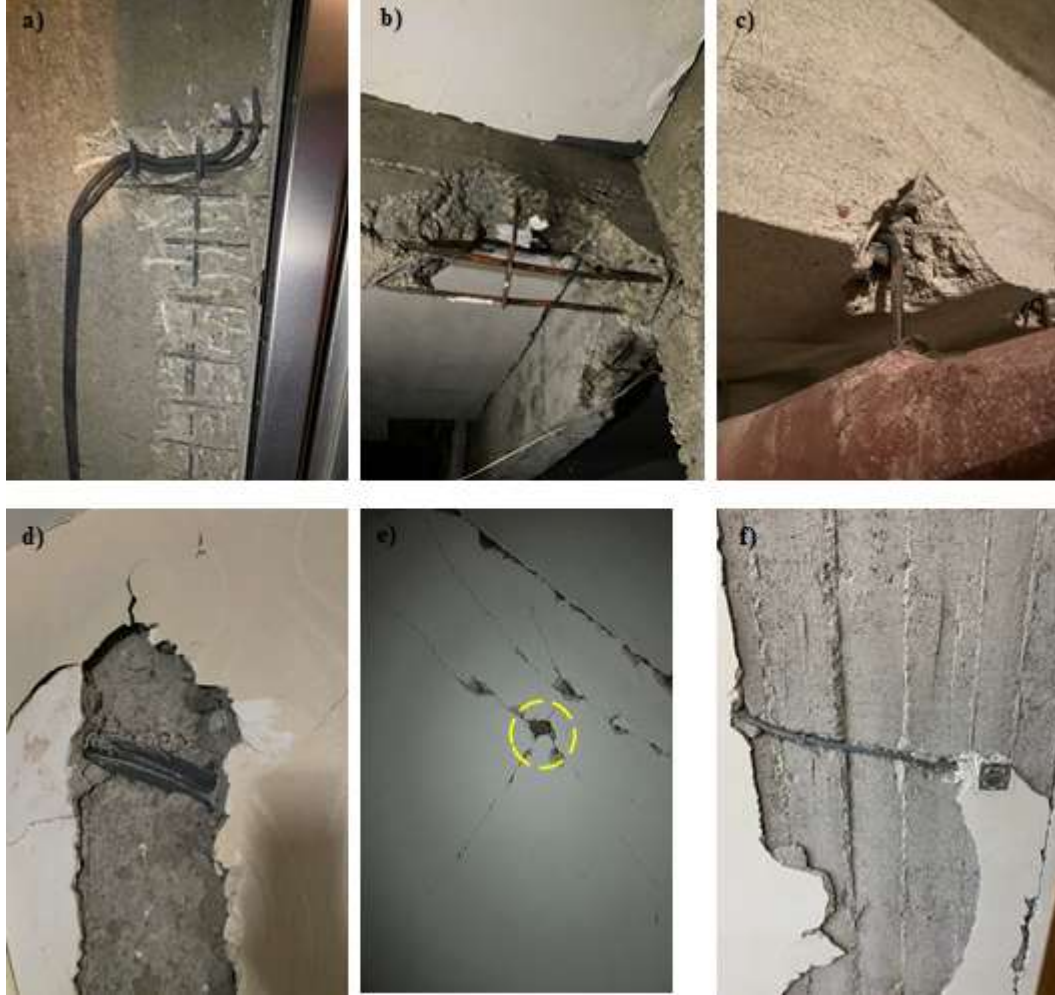
Şekil 8. Taşıyıcı sisteme zarar veren işlemler
