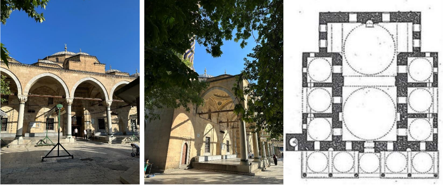
Şekil 10. Gedik Ahmet Paşa Camii günümüz fotoğrafları (Bedra Çeşminaz Kar) ve plan şeması (Eyice, 1962)
