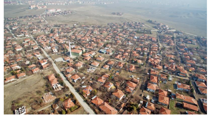
Şekil 3. Saraycık Mahallesi'nin Kentsel Dönüşüm Öncesi Görünümü (Sincan Belediyesi, 2020)
