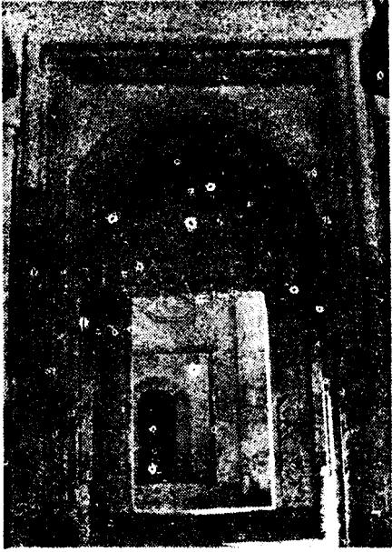
Resim 12: Selâmlıktan Camie geçiş kapısı (içten).
