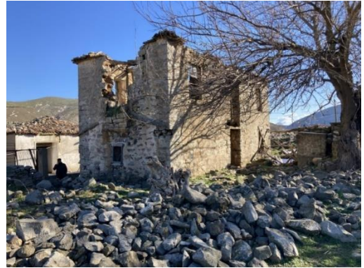
Resim 4: Halaka Mahallesi, Tescilli Kültür Varlığı Örneği (Çanakkale KVKBK Arşivi, 2022).
