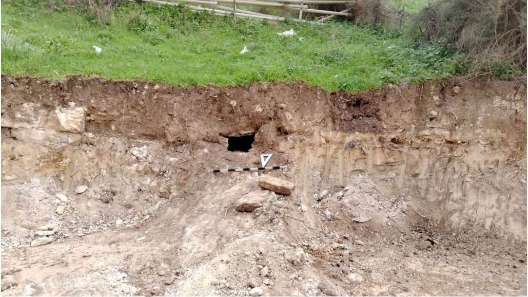
Resim 3: Çalışma sırasında açılan bu delik, su toplama tünelinin yamaçtan içeriye doğru açılan ağız üst kısmına denk gelmektedir.
