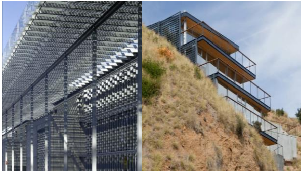
Şekil 6. Yapıya entegre ve kontrol edilebilir ışık rafları (Integrated and controllable light shelves) [133]
