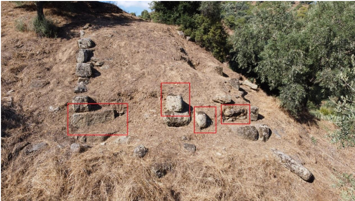
Resim 9: Değirmenönü Kule, cepheden görünüm ve atkı bloğu kullanımı.
