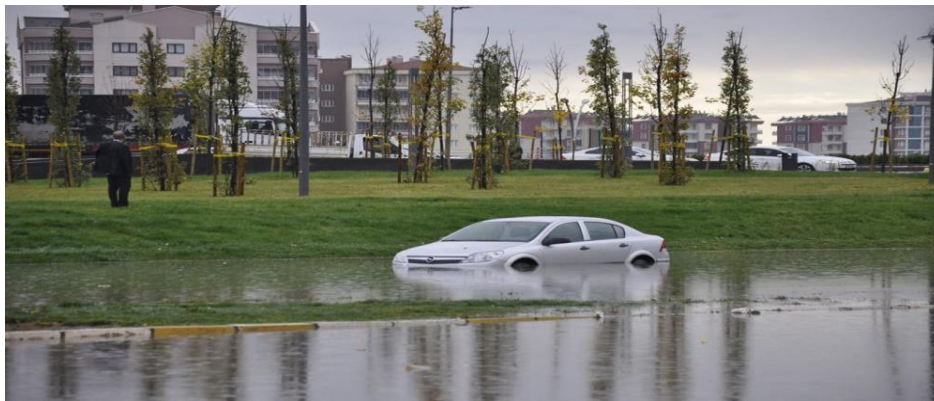
Şekil 8. Nazım Hikmet Caddesi- Mahabad Bulvarı arası yolun yayılma genişliğinin aşılmasından kaynaklı oluşan manzara [15].
