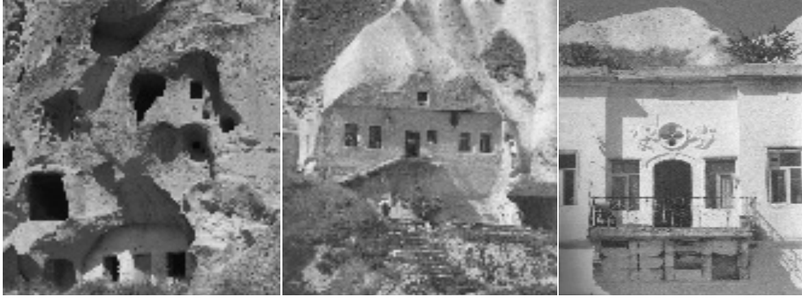
Şekil 13: Tamamı kaya içine oyulmuş olan evler Şekil 14: Bir bölümü kaya içine oyulmuş evler Şekil 15: Taş işçiliği
