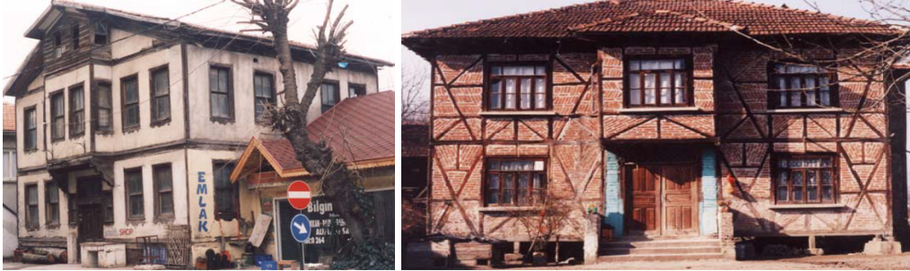
Şekil 2. 1999 depreminde hasar almamış geleneksel ahşap yapılar (Aksoy & Ahunbay, 2005)
