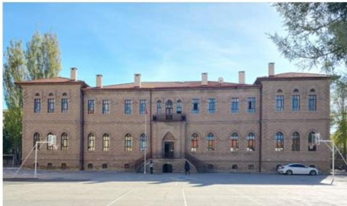
ŞEKİL 3. Aksaray Lisesi Batı Cephe Görünümü
