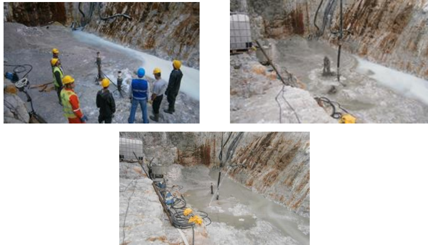
Şekil 20. SP-1 ve SP-2 kaynaklarının ıslahı çalışmaları
