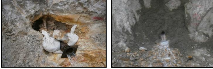
Şekil 16. Küçük çaplı karstik boşlukların enjeksiyonu
