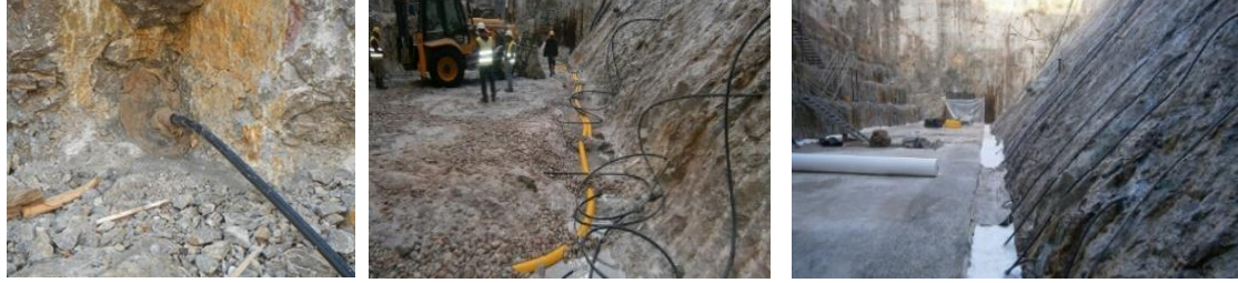
Şekil 21. Şevlerdeki küçük çaplı kaynakların yatay drenaj bağlanması
