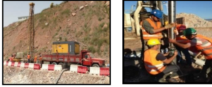
Şekil 10. Sondaj ve pompa yerleştirme çalışmaları
