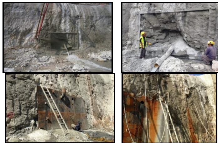
Şekil 15. Karstik boşluğun kazı iç kısmından kapatılma çalışmaları
