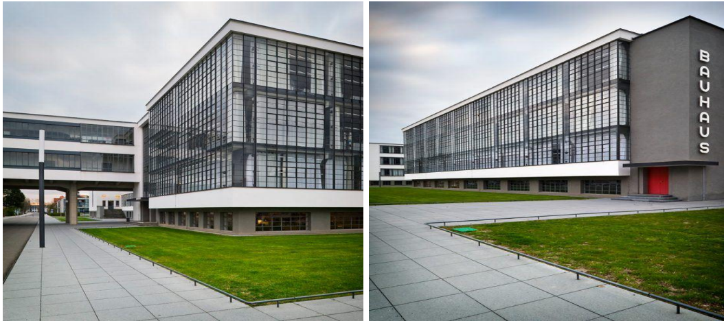
Şekil 6. Bauhaus'ın teknik okul cephesinden çeşitli görünüm (URL-6).
