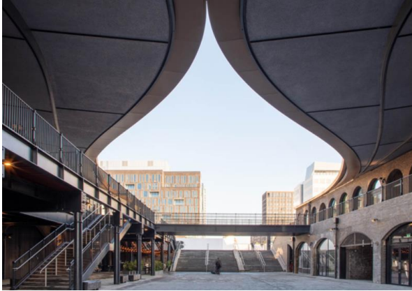
Şekil 7. Yeniden işlevlendirme çalışmaları esnasında çatılara eklenen yapısal öğeler (URL-4).
