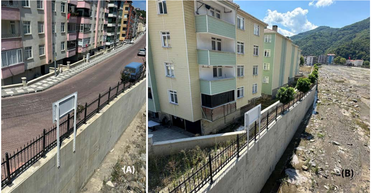
Foto 3: Ezine Çayı'nın Bozkurt yerleşmesi bölümünde, 11 Ağustos 2021 seli sonrasında yapılan 3,5m yüksekliğindeki beton taşkın koruma setleri, yükseltilen yol kotları, yol platformundan -2,4m düşük bina girişleri.
