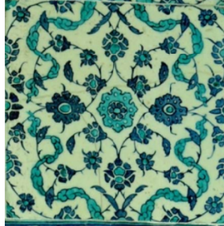
Görsel 7: Bağdat Köşkü, Revan Köşkü iç ve dış duvarlarında, Sünnet odası iç duvarlarında yer alan ulama çinileri
