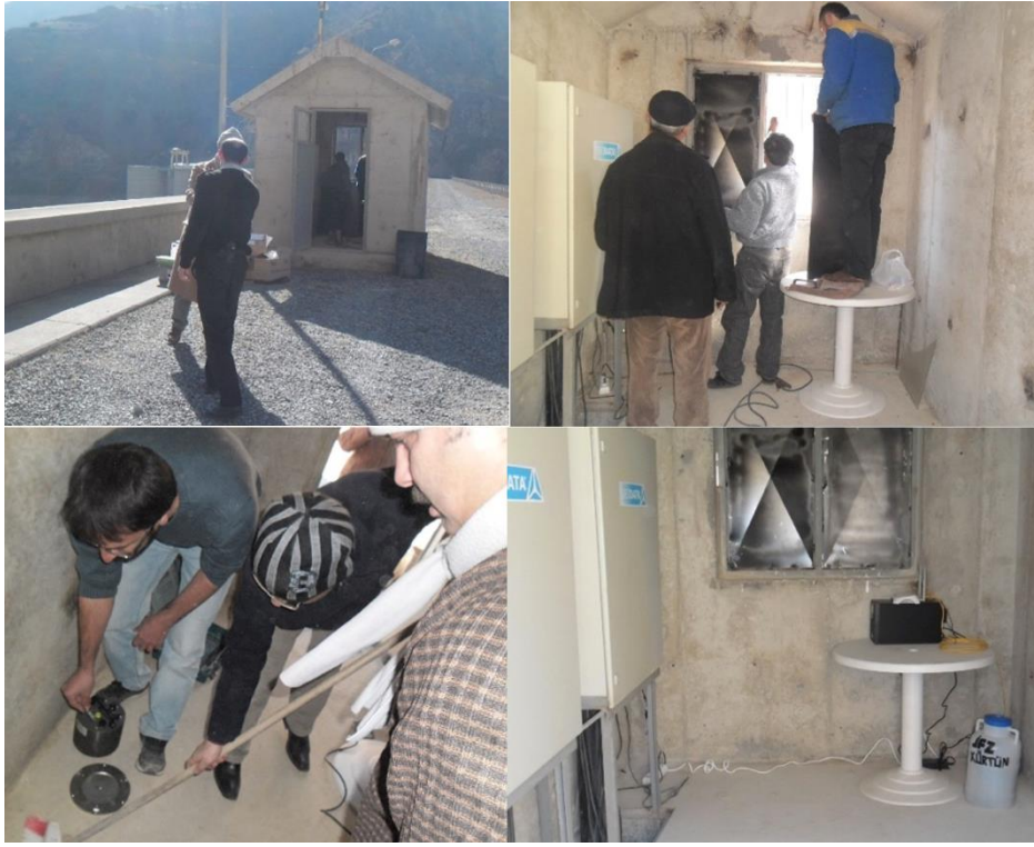
Şekil 4. Kürtün HES ivme kayıt istasyonunun kurulumu.
