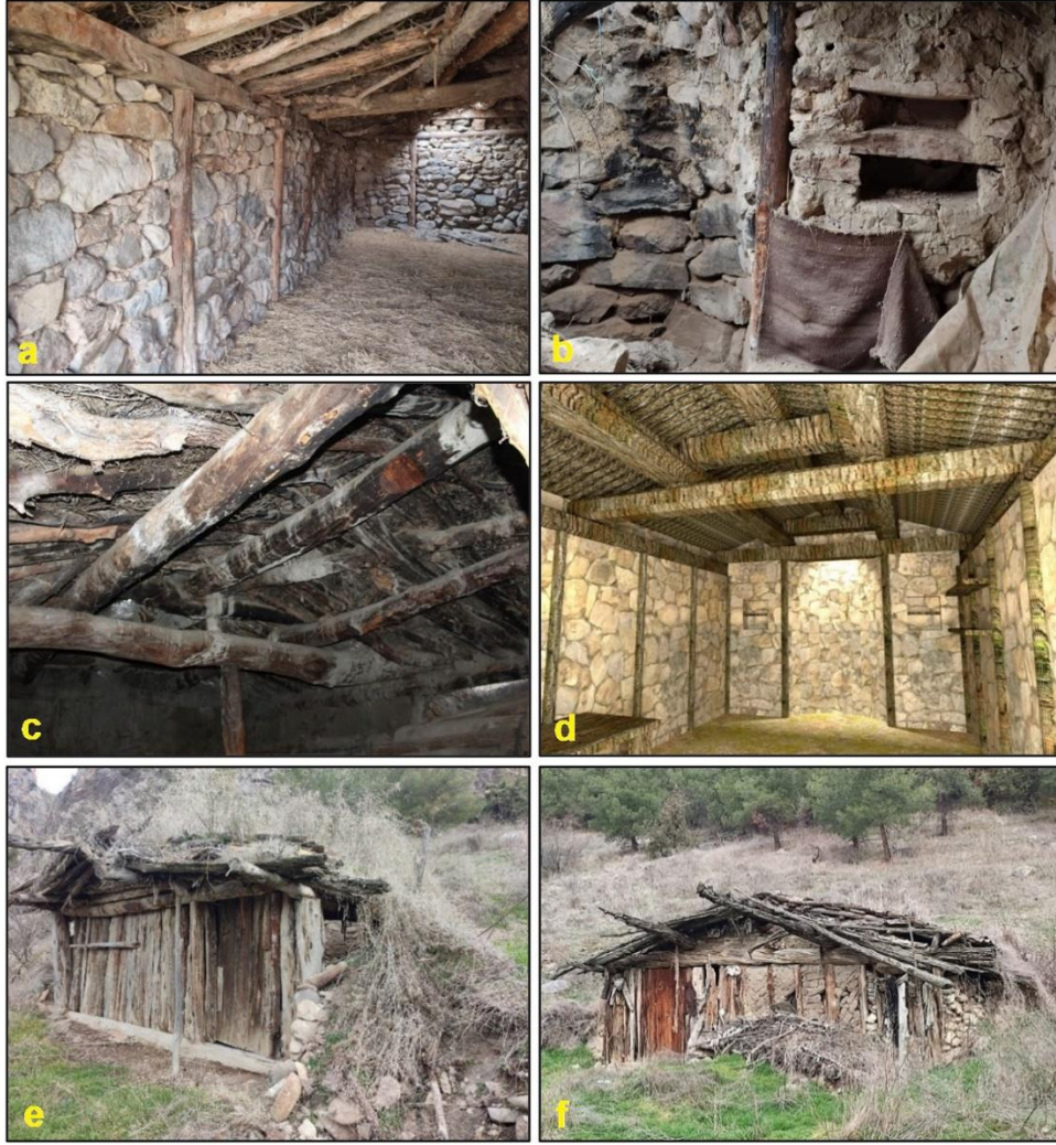
Şekil 7. a) Bermed evlerin içinden bir görünüş. Ahşap düşey hatıllar ve onların üzerinde yatay uzanan yastık kirişi. b) Arka duvardaki ocak yeri ve onun yanında yatay bölünmüş bir niş (Medine gözü). c) Bermed evlerin çatı iskelet yapısının içten görünüşü. d) Bermed evlerin iç görünümü ve taşıyıcı sistemlerin geliştirilmiş çizimi. e) İnal köyünde üç duvarı taş dolgu, cephe duvarı düşey tomruklardan yapılmış bir bermed ev. f) İnal köyünde üç duvarı taş dolgu, cephe duvarı kerpiç dolgulu bir bermed ev.
