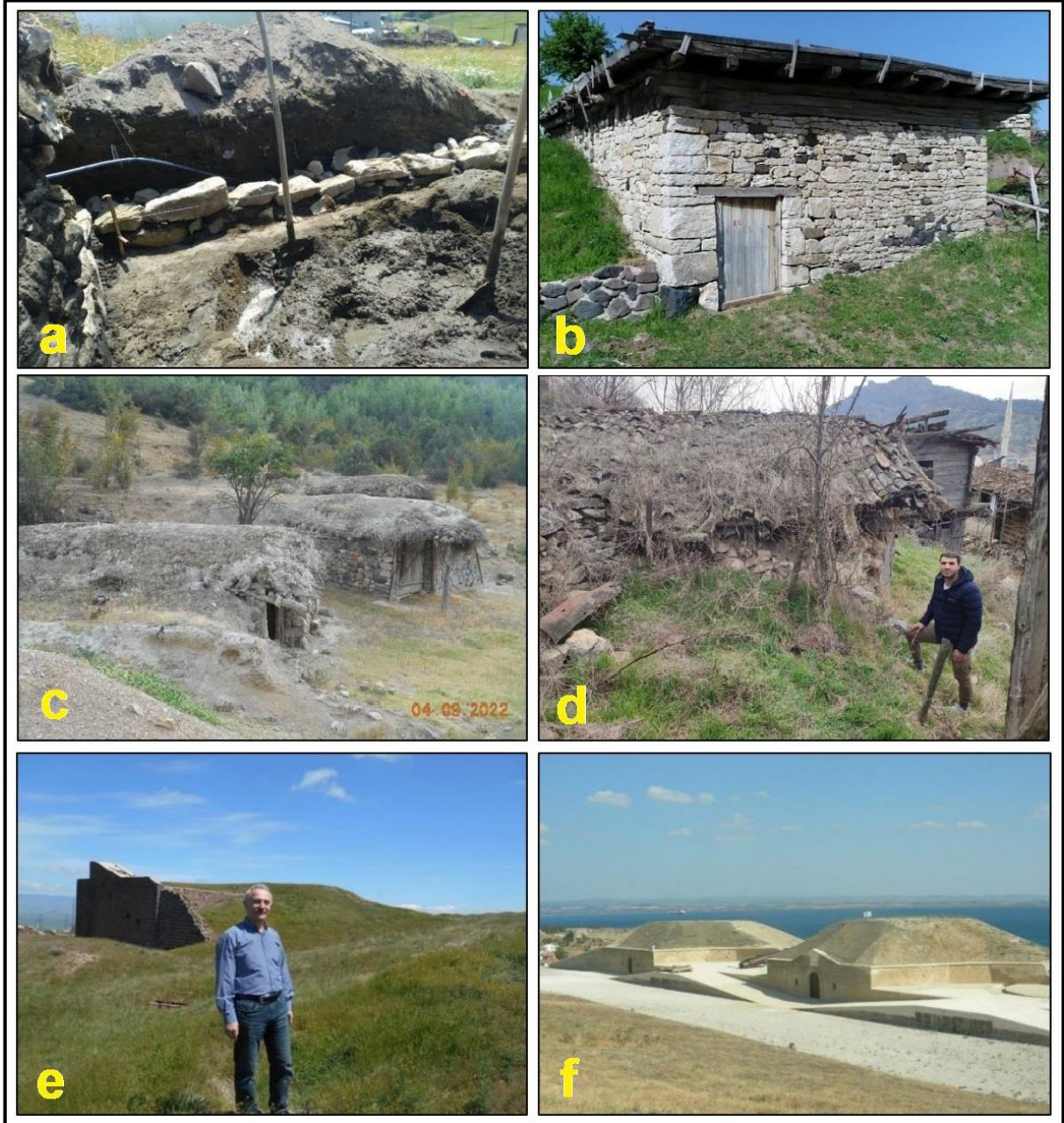
Şekil 2. a) Aydınğün köyünde (Arpaçay, Kars) modern çimento harcıyla inşa edilen bir bermed yapı (Harun Reşit Bağcı'dan 2023). b) Güncel bir bermed yapı. Çakraz köyü (Reşadiye, Tokat), (İsmail Bayram'dan 2023). c) Kamil Köyü bermed evleri: Balina sırtı şekilli, toprak ve çim örtülü çatılar. d) İnal köyünde kiremit örtülü bir bermed ev. e) Savunma amaçlı bir bermed yapı, Aziziye Tabyası, Erzurum, 2016. f) Çanakkale Boğazı girişindeki Seddülbahir tabyalarından bir görünüş
