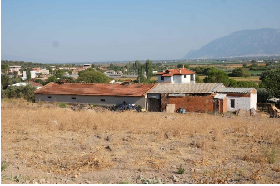
Foto 7. Modern bir konut yapısı ve küçükbaş hayvan ağılı (Bağyolu).
