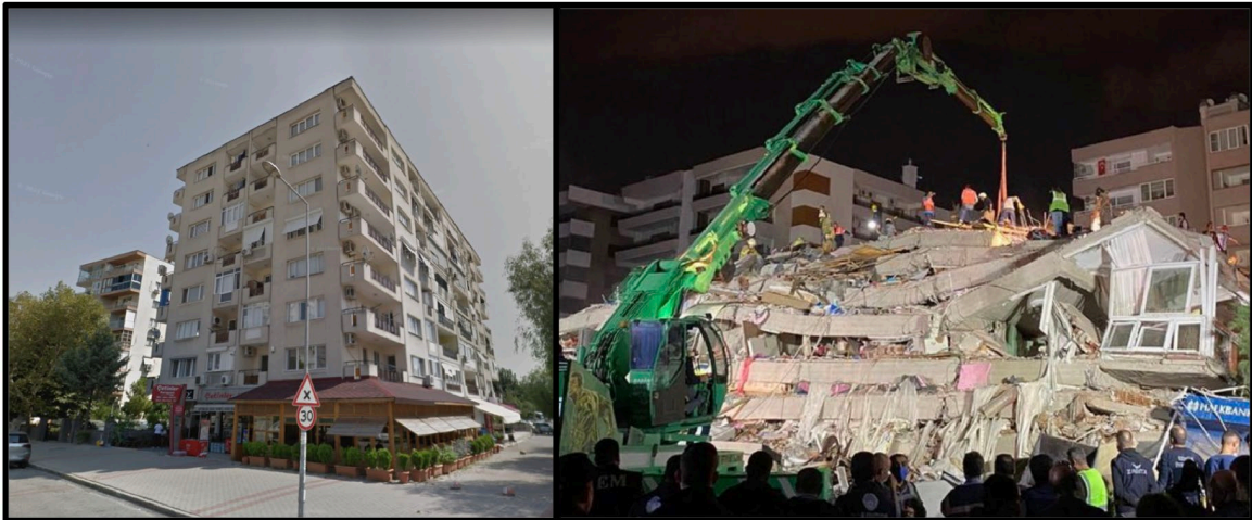
Şekil 25: Doğanlar Apartmanı deprem öncesi ve sonrası (Toptaş 2020) Figure 25: Doğanlar Apartments before and after the earthquake (Toptaş 2020)
