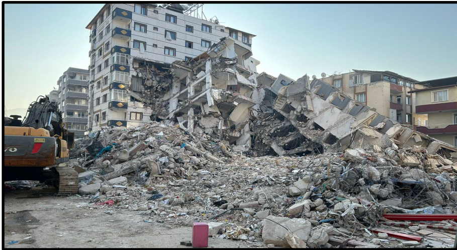
Şekil 4: Burulma davranışı göstererek yıkılmış bir bina, Hatay (TMMOB MO ve İMO İzmir Şb. 2023)
