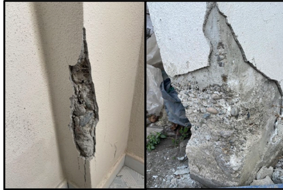
Şekil 21: Uygun olmayan agregası kullanımı, Hatay (TMMOB MO ve İMO İzmir Şb. 2023) Figure 21: Inappropriate aggregate use, Hatay (TMMOB MO and İMO İzmir Br. 2023)
