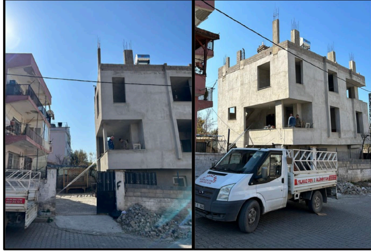
Şekil 14: Taşıyıcı Sistemin Düşey Elemanlarının Süreksizliği, Hatay (TMMOB MO ve İMO İzmir Şb. 2023)
