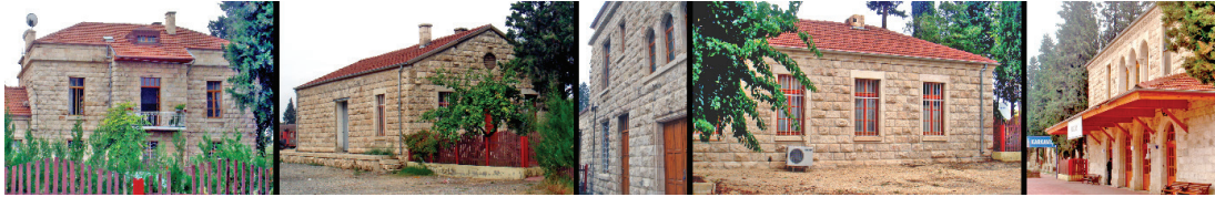
Şekil 3. Karkamış Tren İstasyonu’nda yer alan faal durumdaki farklı yapılardan görünüşler
