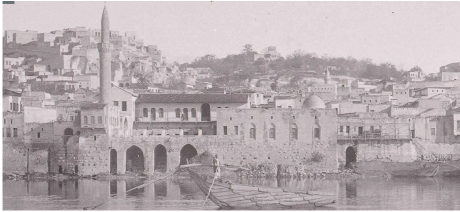
Fotoğraf 13: 20. yüzyılın başlarında Birecik Ulu Camii-Fırat Nehri'ne açılan kemer gözleri ( https://archives.eure.fr/ark:/26335/a011522753757XmaGZj/34ea44f07d ) (Erişim tarihi: 17 Nisan 2024)
