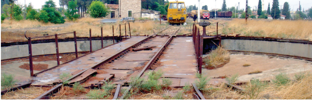
Şekil 6. Karkamış Tren İstasyonu Bakım Havuzu
