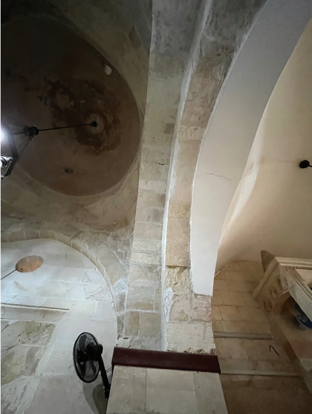
Fotoğraf 6: Birecik Ulu Camii-Maksure kubbesini taşıyan baldaken strüktürün askı kemerlerinin ayağa oturtulma şekli
