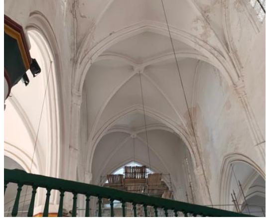
Şekil 7. Yapıya ait kaburgalı çapraz tonozlar.
