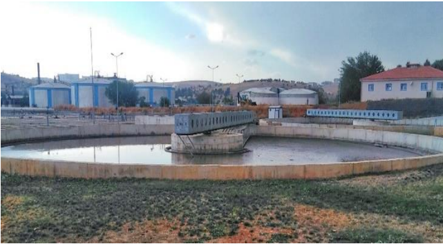
Şekil 9. Ön çökeltme havuzu
