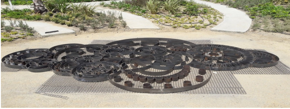
Görsel 7. Tasarımın metal altyapısının uygulama alanına yerleştirilmesi.
