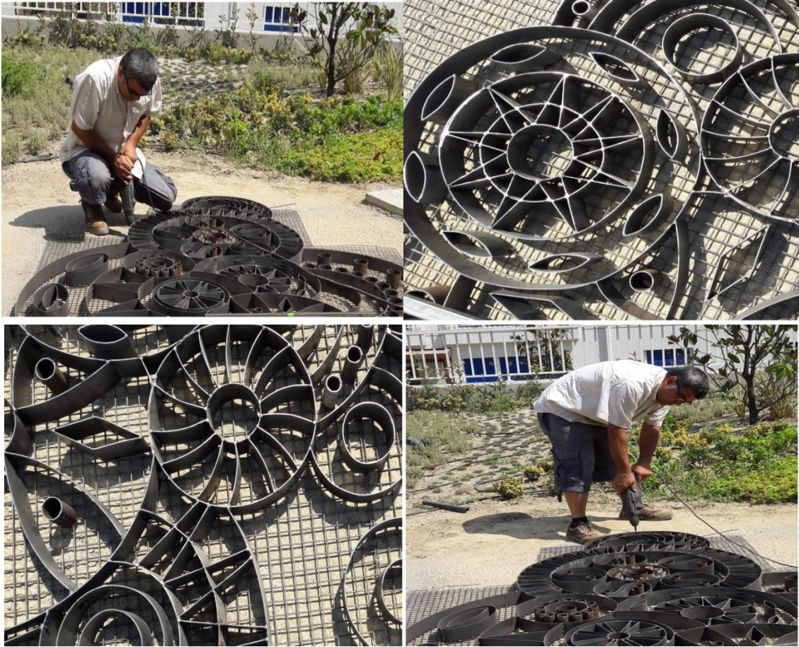
Görsel 9. Metal konstrüksiyonun uygulama zeminine farklı noktalardan çelik çubuklarla ankre edilmesi.
