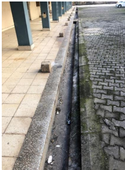
Şekil 17. Yalı Apartmanı drenaj detayı (Kaynak: Funda Alyanak Kaya kişisel arşivi, 2022)
