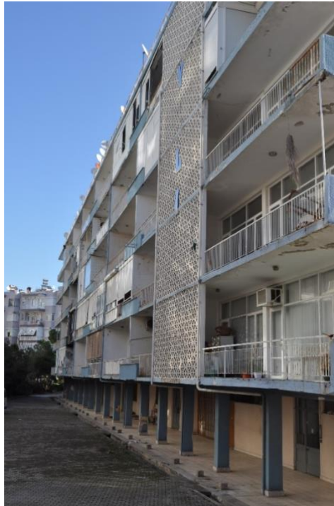
Şekil 9. Yalı Apartmanı’nın pilotileri (Kaynak: Beste Sabır Onat kişisel arşivi, 2022)
