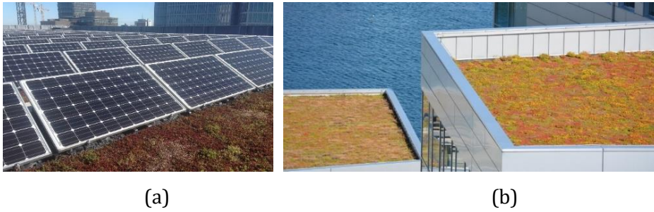
Şekil 21. Yapının sürdürülebilirlik kapsamında tasarlanan bazı uygulamaları, (a) Konser salonu kütesinin çatısına yerleştirilen güneş panelleri (Solect Power, n.d.), (b) Malmö Live'e ait yeşil çatılar (BMI, n.d.)
