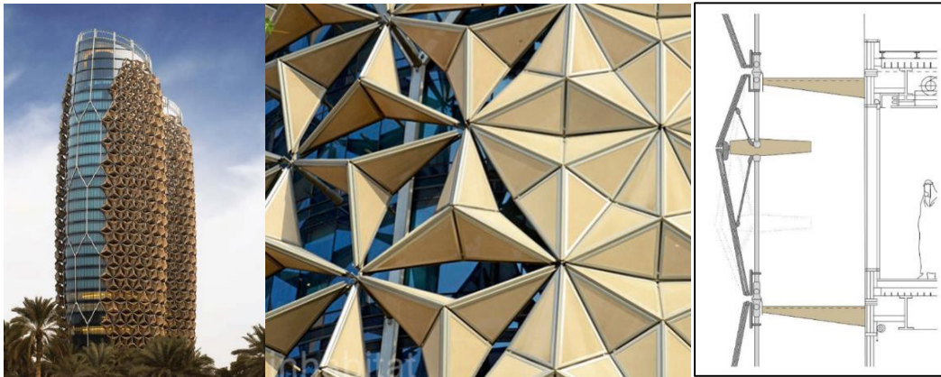
Şekil 7. Al bahar Kuleleri (Wilkinson ve Wood, 2012)
