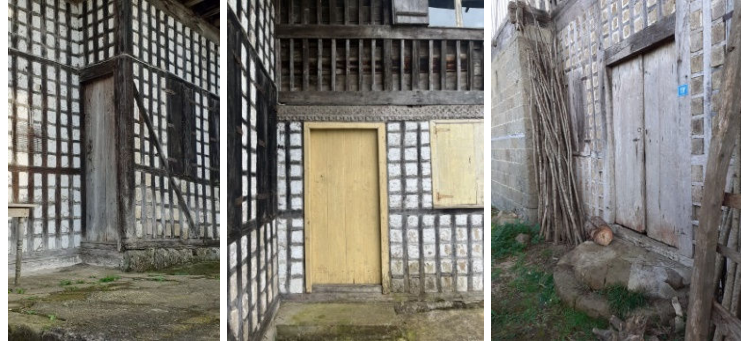
Şekil 13. Batı Cephesinde Bulunan Misafir Odası Girişi, Ek Yapı Girişi ve Kuzey Cephesinde Yer Alan Depo Girişi
