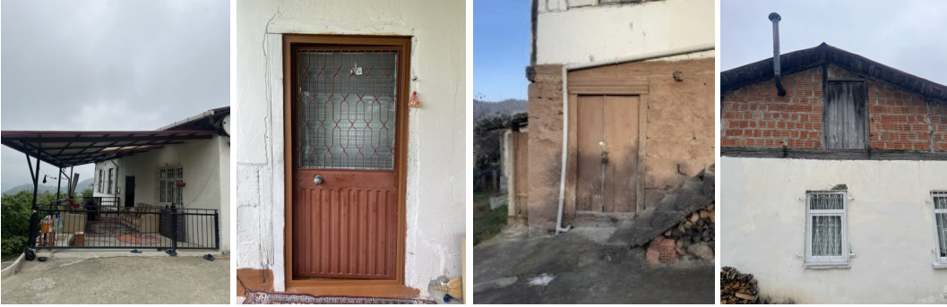
Şekil 23. Evin Batı Cephesinde Bulunan Giriş Sundurması, Batı Cephesinde Yer Alan Ana Giriş, Batı Cephesinde Bulunan Ahır Girişi (Sağda) ve Tuvalet Girişi (Solda) ve Güney Cephesinde Bulunan Kullanım Dışı Eski Çatı Girişi
