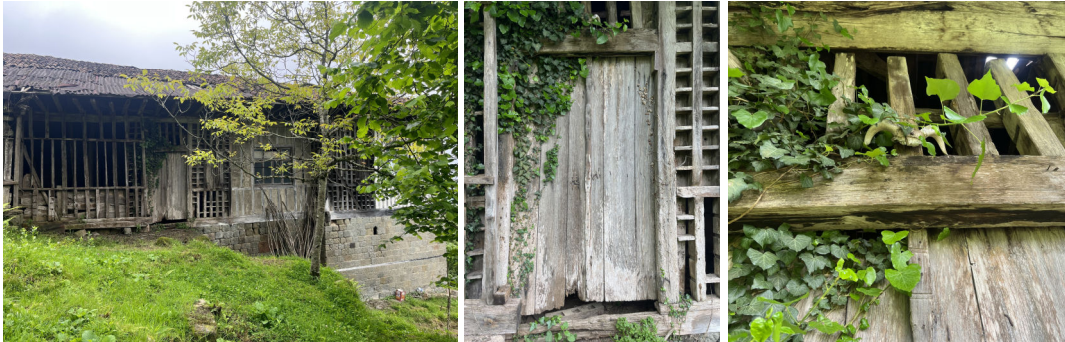
Şekil 14. Evin Doğü Cephesi ve Girişleri, Doğü Cephesi Ana Girişi ve Ana Girişin Üzerinde Bulunan Boynuzu Detayı
