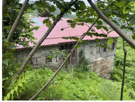
Şekil 18. Doğu Cephesinde Bulunan Ana Giriş (Solda) ve Ahır Girişi (Sağda)
