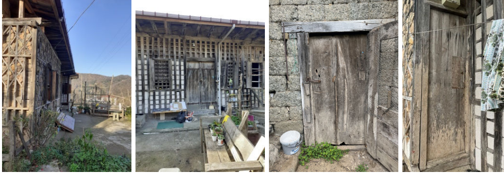
Şekil 10. Evin Doğu Cephesinde Bulunan Ana Girişe Yaklaşım Yolu, Doğu Cephesinde Yer Alan Ana Giriş, Doğu Cephesinde Bulunan Ahır Girişi ve Doğu Cephesinde Yer Alan Misafir Odası Girişi
