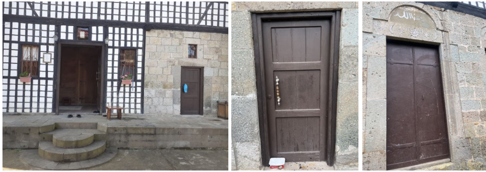
Şekil 6. Haşım Ağa Konağı'nın Doğu Cephesinde Yer Alan Ana Giriş ve Misafir Odası Girişi, Doğu Cephesinde Bulunan Misafir Odası Girişi ve Kuzey Cephesinde Yer Alan Misafir Odası Girişi
