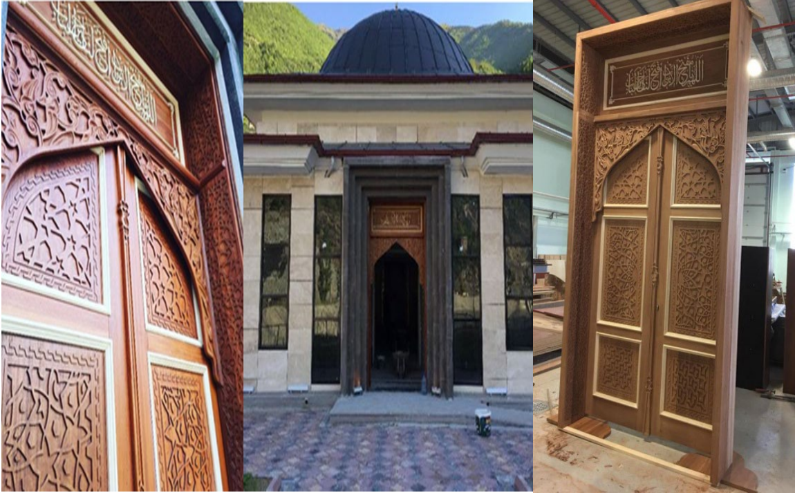
Şekil 23. Dış ana ahşap kapı (taç kapı) ön cephe.
