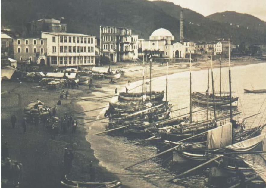
Fotoğraf 1: Hacı Miktad Camii Genel Görünüş (Trabzon Vakıflar Bölge Müdürlüğü Arşivinden)
