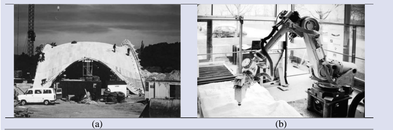
Resim 10. (a) Kompleks çatı formu ahşap kalıp oluşturulması, (b) EPS köpüğün oyularak kalıp oluşturulması Figure 10. (a) Creating a complex roof form wooden mold, (b) Creating a mold by carving EPS foam
